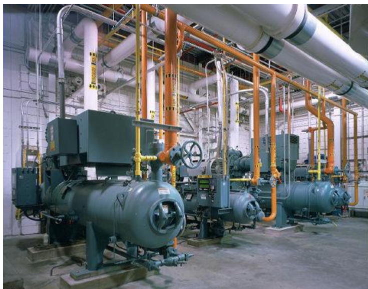
Компрессоры системы централизованного холодоснабжения большой производительности
